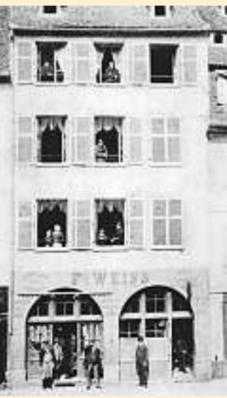
L'ancien magasin de vente, rue des Bouchers à Strasbourg. (Document remis)
